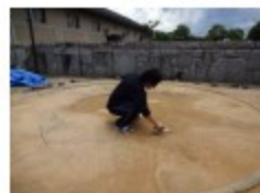
外土俵の補修作業
